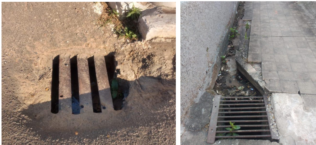
Figura 46 - Bocas de lobo
