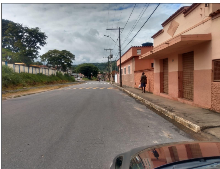
Figura 33 - Calçada estreita em rua central de Ribeirão Vermelho
