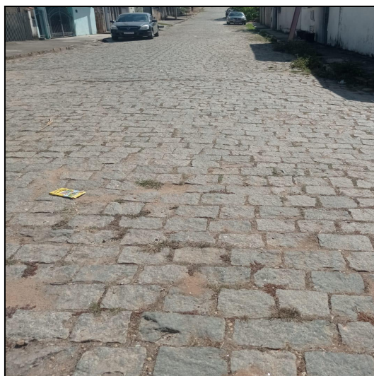
Figura 27 - Rua revestida com paralelepípedo
