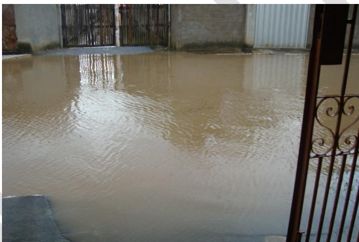
Figura 22 - Falta de drenagem pluvial Rua José Evaristo da Costa.
