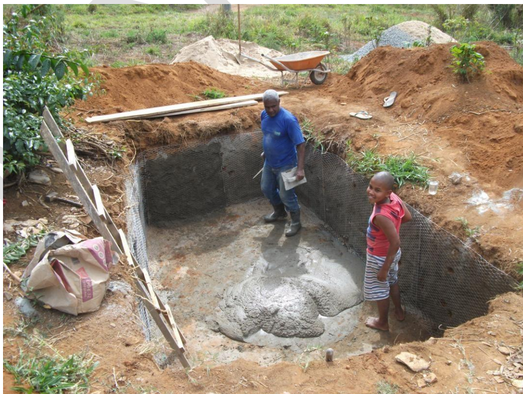
Figura 18 - Construção e apresentação da Unidade Demonstrativa.
