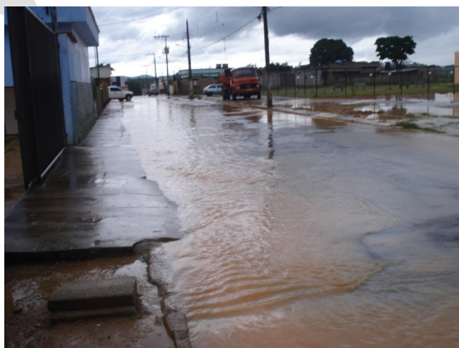
Figura 23 - Falta de drenagem pluvial Rua João Francisco Lopes.
